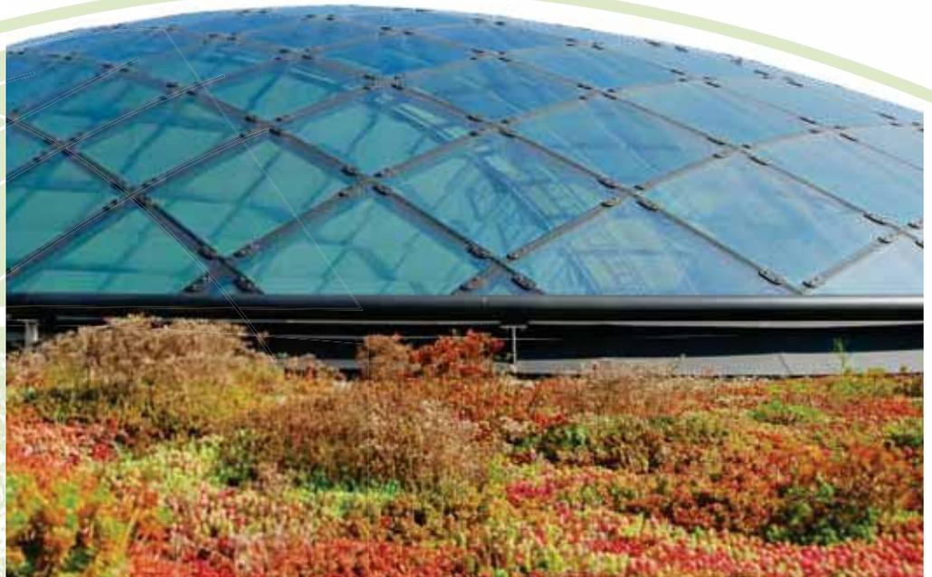
El sistema "Sedum tapizante" es una estructura estándar de las cubiertas verdes extensivas. Es un sistema ligero de poco espesor con una atractiva apariencia natural que requiere escaso mantenimiento.
