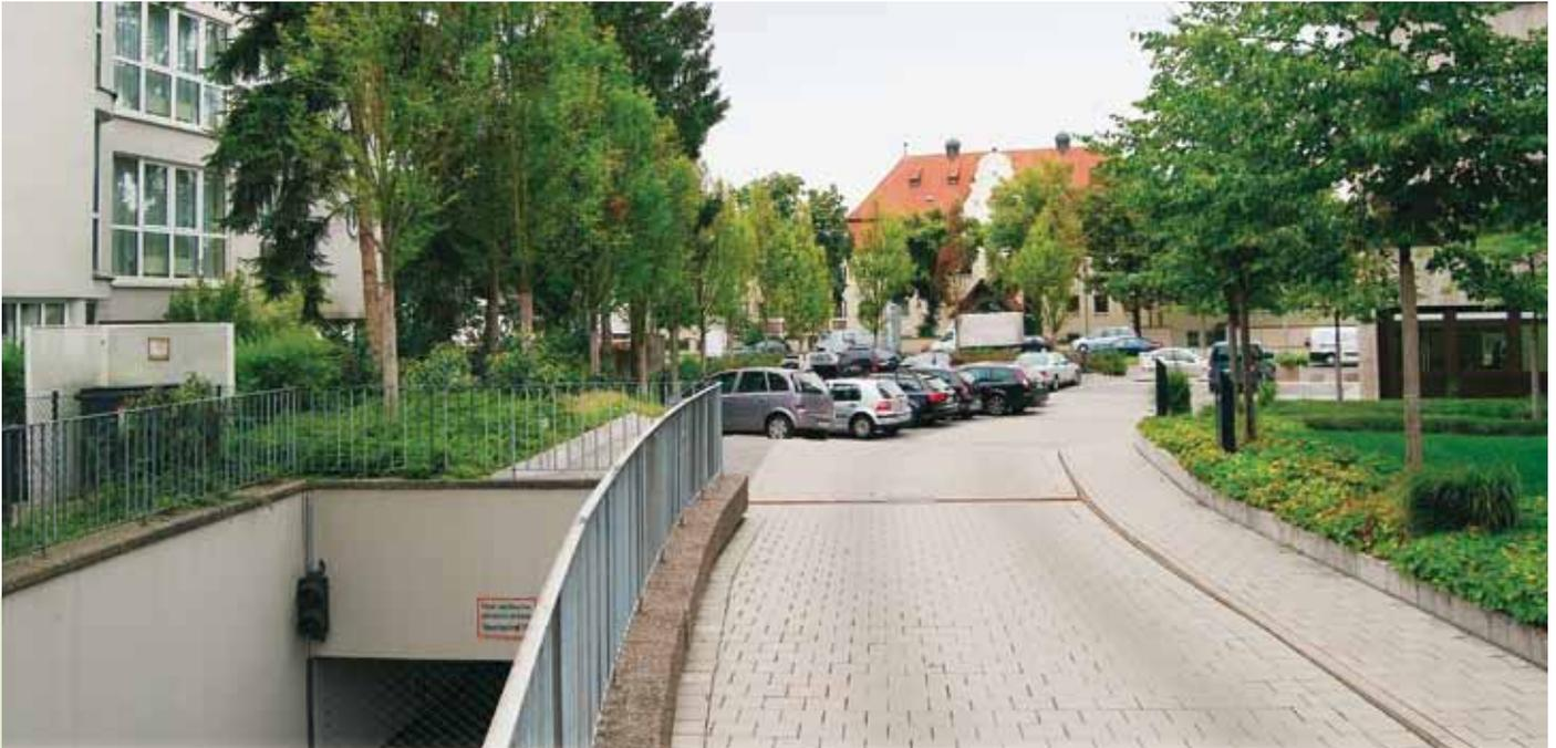
El tránsito de vehículos en las cubiertas requiere tanto de una construcción como de un sistema que puedan soportar las cargas generadas por los vehículos. Además, el tráfico de vehículos en una cubierta genera importantes presiones horizontales y movimientos de torsión por la aceleración, el frenado y la conducción, que deben ser absorbidas por la estructura.
