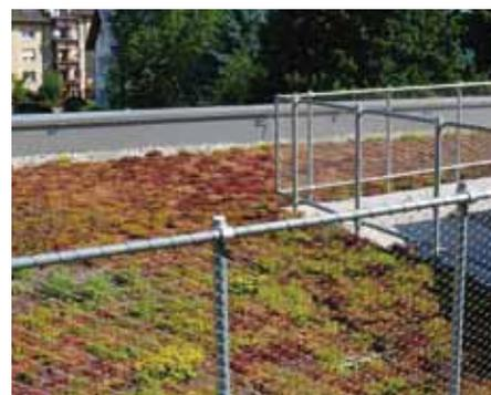
Sistema de base para barandillas ZinCo es atractivo y funcional, y además se instala sin necesidad de perforar la impermeabilización.
