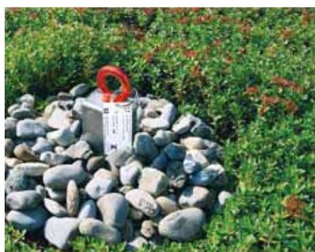
Cada instalación de Fallnet® SR se registra por nuestro departamento de ingeniería con una marca de identificación en el punto de anclaje. Esta marca indica el nombre del producto, la norma de ensayo, la fecha de producción del módulo y el número de serie del mismo. Esta información permite identificar al ingeniero y al instalador del sistema, aunque haya pasado mucho tiempo desde la ejecución.
