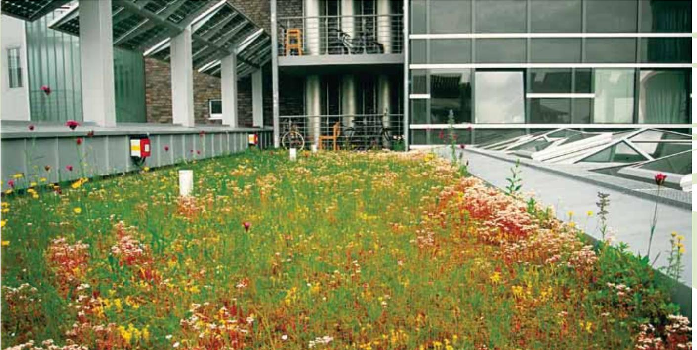
Por norma general, las cubiertas planas deben tener una pendiente de, al menos, un 2°. Esto es especialmente importante en el diseño de una cubierta verde extensiva con una capa de drenaje y de sustrato de poco espesor. Ahora bien, en el caso de las cubiertas con pendiente 0°, es vital aumentar la altura de la placa drenante para evitar que los posibles encharcamientos produzcan la asfixia de las raíces de la vegetación.
