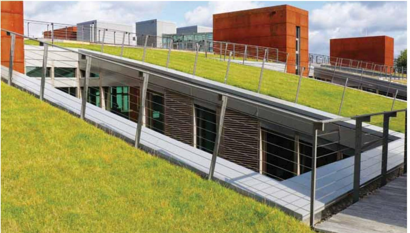
El sistema tipo "Cubierta verde inclinada hasta 35°", basado en los elementos Georaster® de ZinCo, permite la instalación de cubiertas verdes en pendientes superiores a 20° y hasta 35°. En casos especiales, los ingenieros de ZinCo pueden diseñar soluciones excepcionales para cubiertas con pendientes superiores a 35°.
