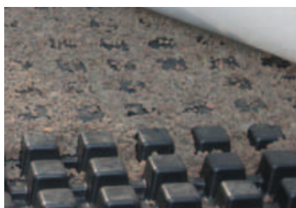
Cuando las placas SD 30 se instalan con los nódulos hacia arriba, el volumen de relleno entre nódulos es de 20 l/m 2 aprox.
