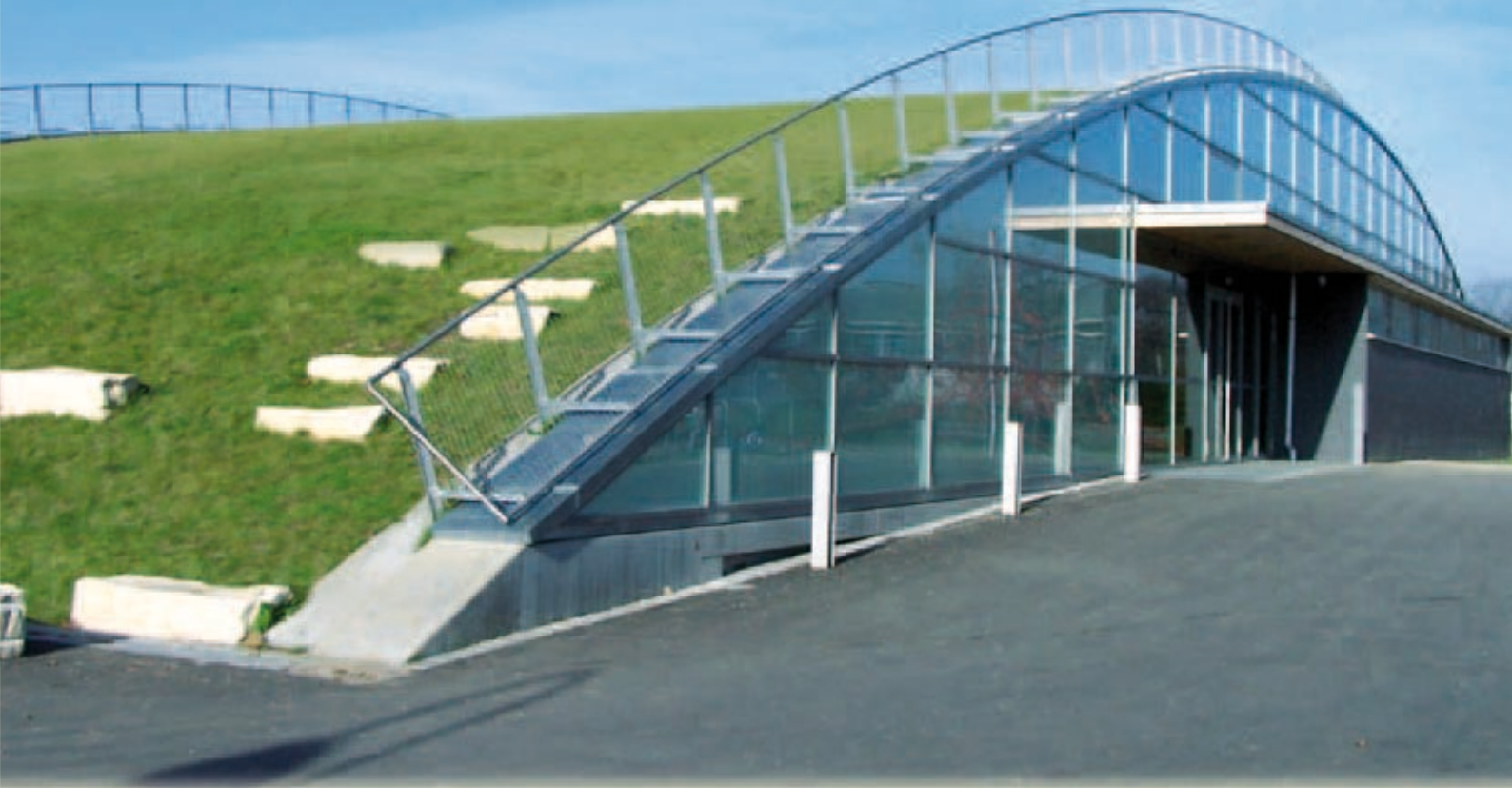
La superficie total de la cubierta del gimnasio del Colegio Clara Grunewald en Friburgo (Barrio de Rieselfeld) mide aprox. 1000 m 2
