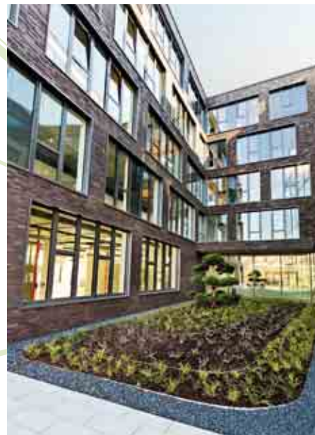
Patio realizado con el sistema “Cubierta reguladora de cargas pluviales” sobre un garaje subterráneo en la ciudad de Ratingen, Alemania
