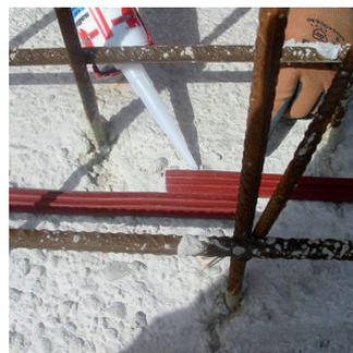
**4.** Realizar el solape colocando la junta en paralelo unos 5 cm. No superponer. Podemos utilizar MS Polímero para regularizar el soporte Art. N. 0893 225.
