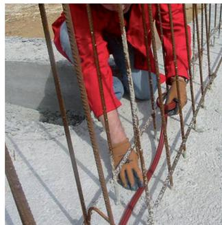
**2.** Colocar el perfil WATERSTOP DM entre las varillas de ferralla.
