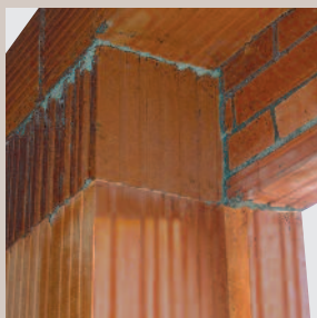
Linthead pour volet roulant monobloc avec brique Feuillure 12.
