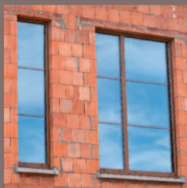
Linthead pour volet roulant monobloc avec brique Feuillure 12.
