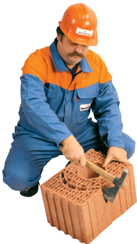
Séparation des éléments du poteau multi-angles.
