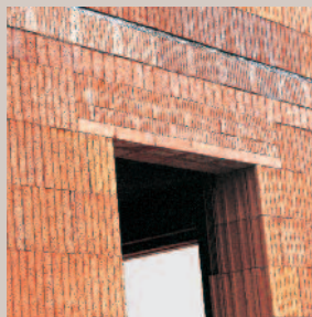
Linteau avec prélinteau et briques de compensation.
