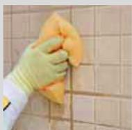
Amasar **weber.color junta ancha** con 1,2 litros de agua limpia por bolsa de 5 kg, manualmente o con un batidor eléctrico lento (500 rpm), hasta obtener una masa homogénea y exenta de grumos. Dejar reposar la mezcla dos minutos.
