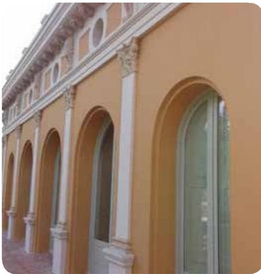
**weber.therm moldura** es un conjunto de molduras y elementos ornamentales prefabricados a partir de poliestireno expandido de alta densidad estabilizado cortados con máquinas de elevada precisión, y recubiertas con un mortero polimérico.
