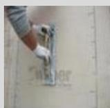
Incorporar sobre la primera mano en fresco **webertherm malla 160** en todo la superficie solapándola 10 cm en los encuentros de esta, y adherir mediante el paso de una llana sin apretar en exceso para evitar retirar el material. Y por último aplicar la segunda mano de material.
