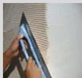
Aplicar **webertherm flex B** con una llana de acero inoxidable en dos manos, con un espesor de aplicación por capa de 1 - 2 mm.
