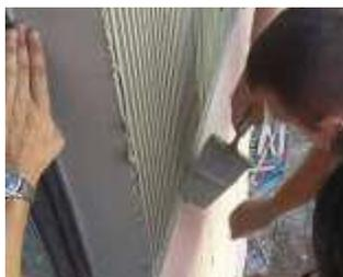
La pieza cerámica se debe apretar bien contra el soporte para repartir homogéneamente el mortero cola y aplastar los surcos de la llana dentada, asegurando el contacto en toda la superficie (mínimo 90%); levantar la pieza para verificar que la pieza queda bien macizada y que no existen zonas sin contacto con el soporte. El espesor de la capa de mortero cola final que queda es de unos 5 – 7 mm.
