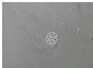
La **tercera capa**, destinada a regularizar y recibir el aplacado cerámico, debe garantizar la correcta cobertura de la malla y de las espigas de fijación. La malla y las espigas deben quedar cubiertas en la totalidad, y se deberá dejar una superficie plana, sin resaltos y con una textura constante en toda la superficie con el paso de la llana a 45° para abrir el poro cuando el material haya comenzado a endurecer.
