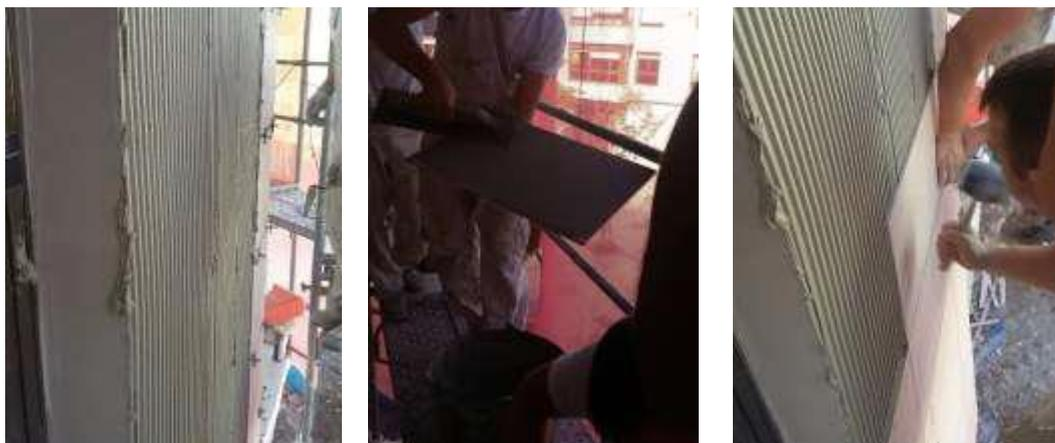
Muy importante una vez colocada la pieza pasar la llana alrededor de los bordes que quedan libre, especialmente en el borde horizontal superior, para sellar completamente con mortero cola el espacio entre pieza y soporte.
