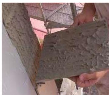
Retirar los restos de mortero cola de la junta, dejando el espacio entre baldosas libres de pasta, y así poder asegurar un espesor de junta constante.
