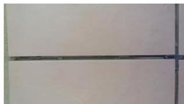
La superficie se rejuntará una vez hayan pasado un mínimo de 3 días desde la adhesión de las piezas cerámicas, y se realizará con el mortero de rejuntado **weber.color premium**; para dotar de una hidrofugacidad extra a la junta se puede aplicación posteriormente de un hidrofugante en base agua. Prever juntas de dilatación entre piezas cerámicas con un ancho mínimo de 8 mm, que serán rellenadas con el mortero de rejuntado definido en el punto 4.6.
