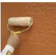
Acabado texturado: tras extender el producto, proyectar el árido de cuarzo sobre la superficie y texturar con el rodillo elegido. Igualmente se puede texturar fácilmente mojando el rodillo con un desmoldeante y procediendo al texturado. Se recomienda no proyectar directamente el desmoldeante sobre el producto.
