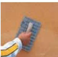
Acabado raspado: una vez iniciado el endurecimiento, raspar uniformemente con un raspador metálico y cepillar la superficie para eliminar los restos de polvo de manera uniforme.
