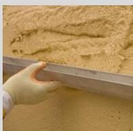
Reglear hasta conseguir una superficie plana, estable y homogénea, con el espesor deseado. Previamente se habrán colocado las reglas metálicas o maestras realizadas con el mismo material, para delimitar las superficies a proyectar y determinar el espesor de aplicación (máximo de 80 mm\*).
