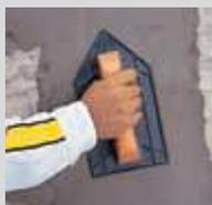
El acabado se realiza fratasando la superficie con una herramienta adecuada (fratás de plástico, madera, pórex...).
