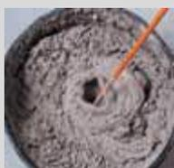
Amasar **weber.tec hormiestetic** con 3,75 – 4,25 litros de agua limpia por saco, según la reología que se quiera obtener. Para obtener un mortero tixotrópico de aplicación con llana, utilizar entrono a 3,75 litros. Para un mortero más fluido de aplicación con brocha, amasar con, aproximadamente, 4,25 litros.
