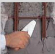
Aplicar **weber.tec hormiestetic** con llana, brocha o rodillo, en capas sucesivas de 1 mm de espesor. El material debe haber empezado a endurecerse antes de aplicar la siguiente capa.
