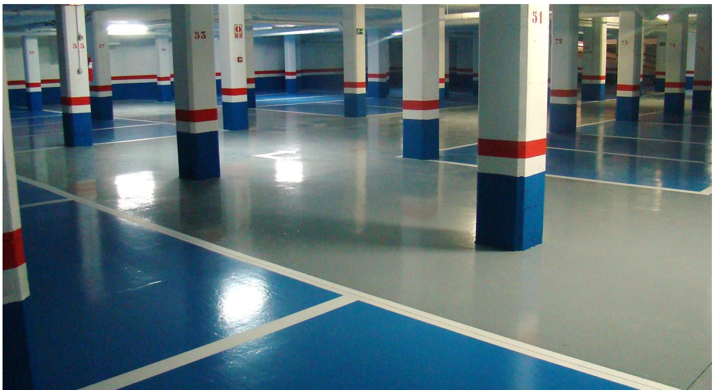
Figura 5.3: Ejemplo de sistema terminado en parking.
