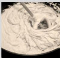
Amasar **webercol flex<sup>3</sup> supergel** con 6,5 -7,5 litros de agua limpia por saco de 25 kg con un batidor eléctrico lento (500 rpm) hasta obtener una masa homogénea y exenta de grumos. Dejar reposar la mezcla unos 2 minutos y realizar un ligero reamasado.
