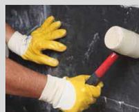
Colocar las baldosas presionándolas hasta conseguir el aplastamiento de los surcos del mortero cola y un buen macizado de la pieza golpeando las piezas con la ayuda de un mazo de goma blanda. Comprobar periódicamente la pegajosidad de la pasta levantando la baldosa previamente colocada. Es aconsejable dejar juntas entre piezas colocando crucetas de 2 mm como mínimo en interiores y 5 mm en exteriores, rellenándolas con morteros de rejuntado de la **gama webercolor**.
