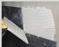
Aplicar en paños pequeños con la ayuda de una llana dentada adecuada. Respetar el tiempo abierto del adhesivo y en caso que se haya formado una película en la superficie del adhesivo y no existe transferencia, eliminar el material y aplicar de nuevo. Efectuar un doble encolado para piezas de gran formato o elevado peso.
