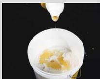
Mezclar el contenido del cubo, amasando el componente A con el componente B con una batidora eléctrica de baja velocidad hasta obtener una masa homogénea. En caso de no amasar la totalidad de los componentes se deben garantizar la proporcionalidad entre ellos.
