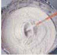
Amasar **weber.col dur** con 7 - 9 litros de agua limpia por saco, manualmente o con un batidor eléctrico lento (500 rpm), hasta obtener una masa homogénea. Dejar reposar la mezcla unos 2 minutos.
