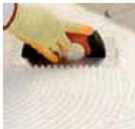
Extender sobre el soporte en paños pequeños (máximo 2 m<sup>2</sup>) y peinar con una llana dentada de 8x8 mm para regularizar el espesor.
