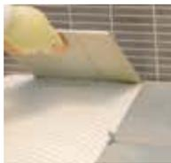
Colocar las baldosas y presionarlas hasta conseguir el aplastamiento de los surcos. Comprobar periódicamente la pegajosidad de la pasta, levantando la baldosa previamente colocada.
