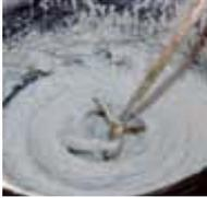
Amasar **weber.col capa gruesa** con 4 - 6 litros de agua limpia por saco de 25 kg, manualmente o con un batidor eléctrico lento (500 rpm), hasta obtener una masa homogénea y exenta de grumos.
