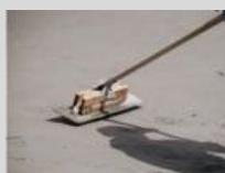
2. Extender el mortero con un espesor mínimo de 3 cm, regleándolo sobre maestras recuperables.
