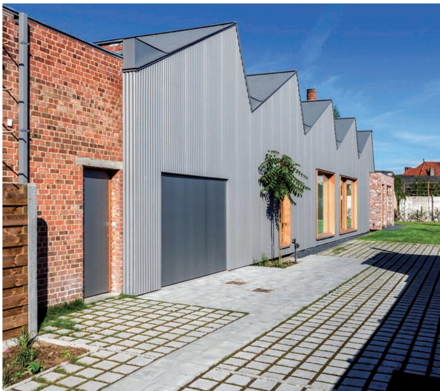
Viviendas y oficinas, Kortrijk (Bélgica) - Arquitecto: KLARTE Architecten - Técnica: Perfil sinus VMZINC® en QUARTZ-ZINC® - Fotografía: Jump Picture
