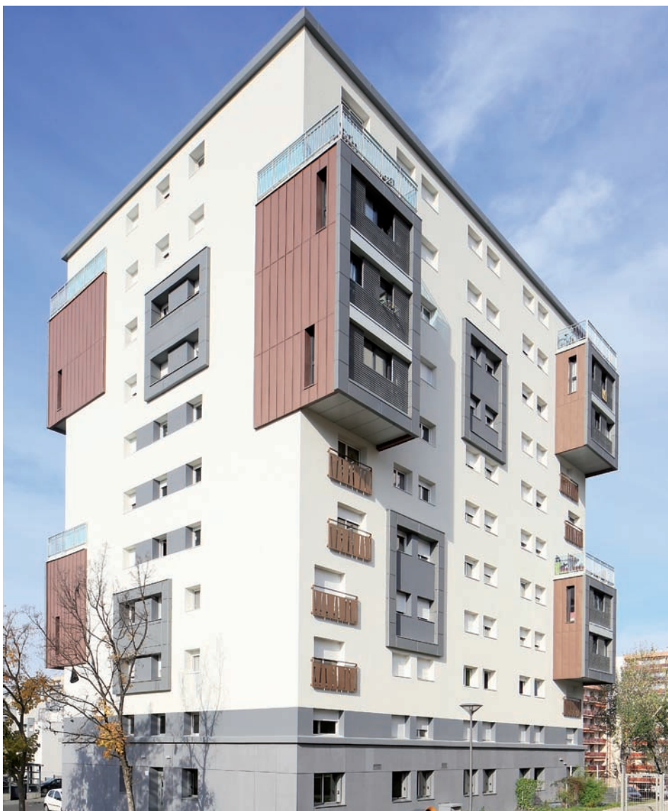
Edificio de viviendas, Clermont-Ferrand (Francia) - Arquitecto: Atelier Imagine - Técnica: Junta alzada VMZINC® en PIGMENTO® rojo tierra, Composite VMZINC® y Perfil sinus VMZINC® perforado en QUARTZ-ZINC®
