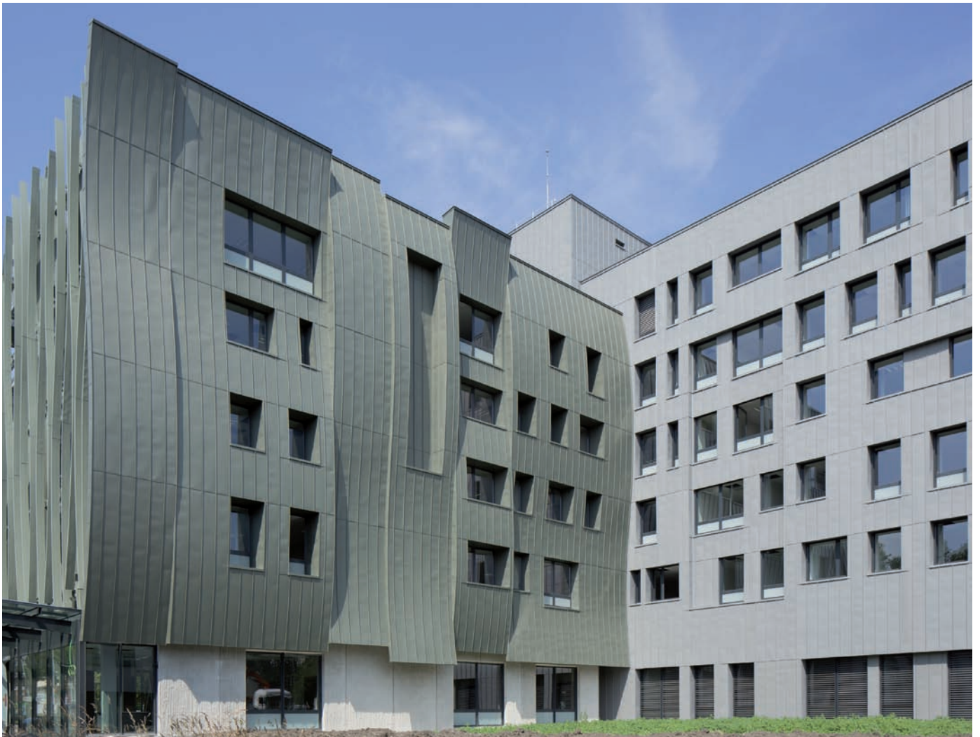
Oficinas Carsat, Clermont-Ferrand (Francia) - Arquitecto: CRR Architectes Técnica: Junta alzada VMZINC® en QUARTZ-ZINC®, PIGMENTO® verde olivo y PIGMENTO® rojo tierra
