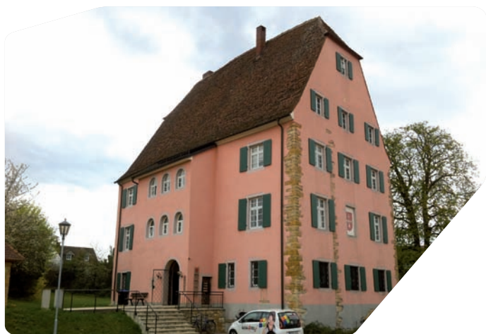
Emeindehaus Eschbach (Alemania) - Arquitecto: Seifert-Eggen - Técnica: Escamas VMZINC® en QUARTZ-ZINC® - Fotografía: Doppstadt Photography
