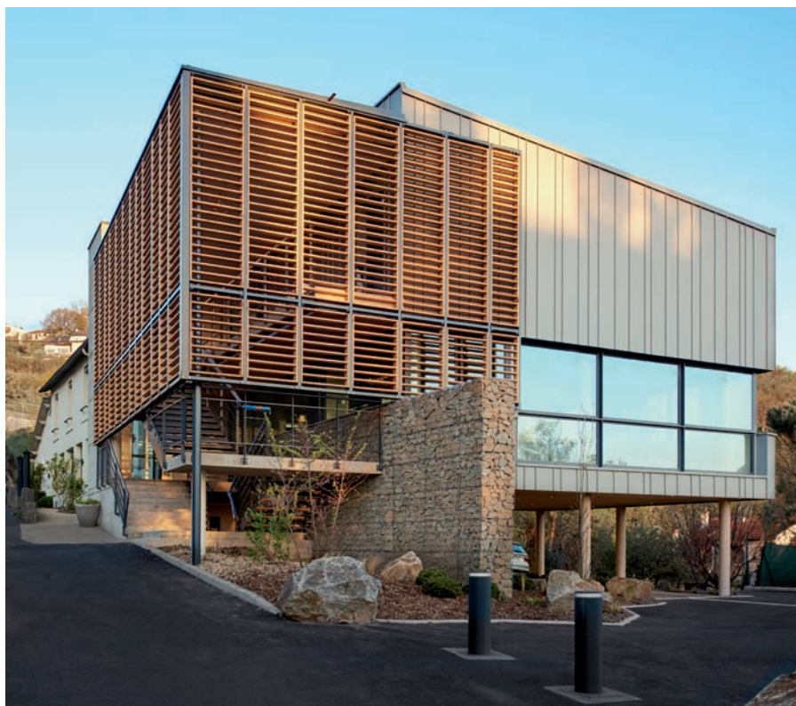
Restaurante Le Pré, Durtol (Francia) - Arquitecto: Mines - Técnica: Junta alzada VMZINC® en QUARTZ-ZINC® Fotografía: Sylvain Jouve
