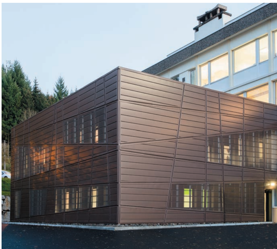
Centro médico, Riomès Montagne (Francia) - Arquitectos: Trinh & Laudat - Técnica: Panel de fachada VMZINC® en PIGMENTO® marrón raíz
