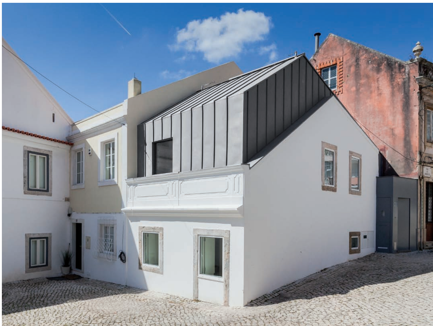
Casa unifamiliar, Lisboa (Portugal) - Arquitecto : Humberto Conde - Técnica: Junta alzada VMZINC® en QUARTZ-ZINC® - Fotografía: Joao Morgado-fotografía de arquitectura
