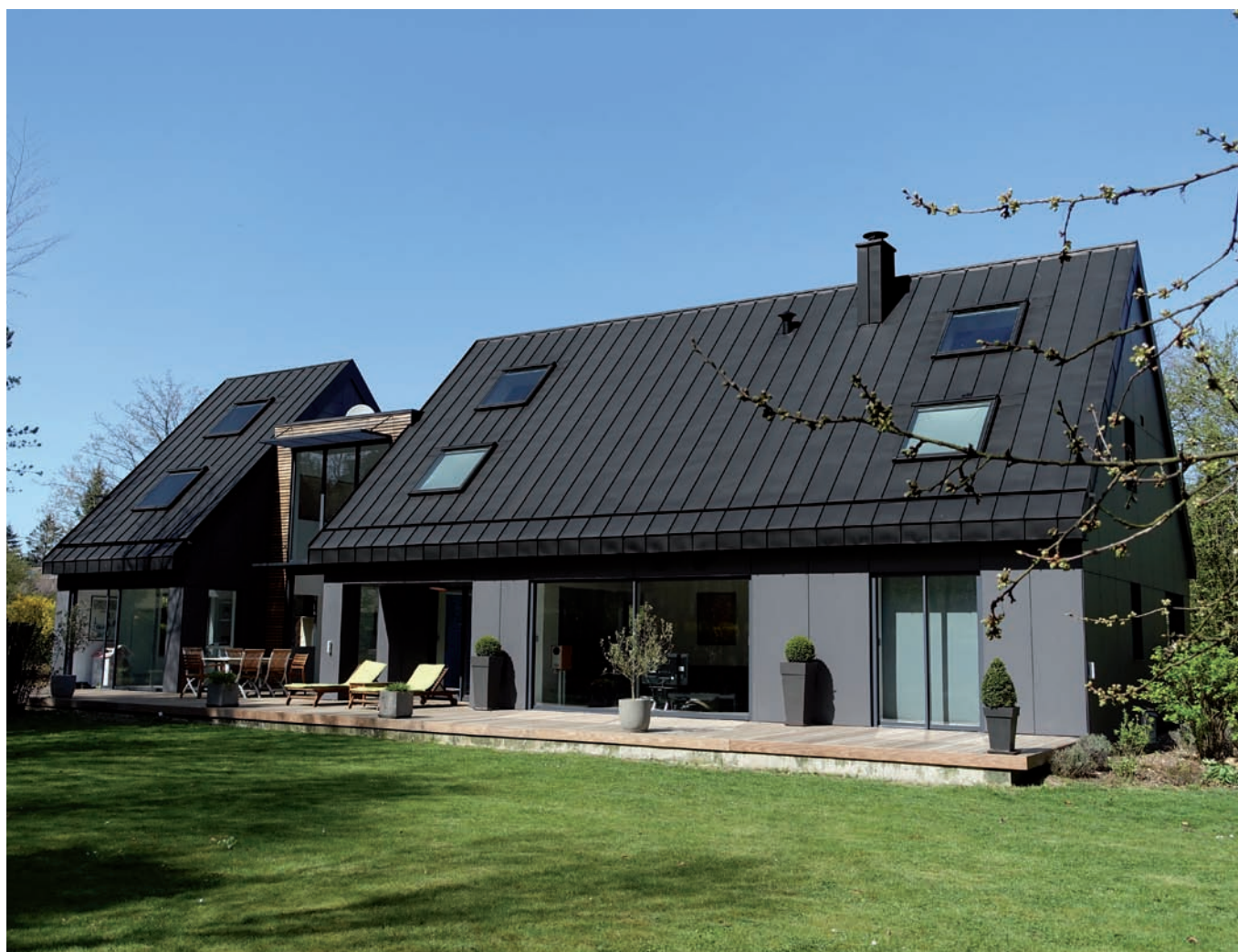
Casa unifamiliar, Sains-en-Amiénois (Francia) - Arquitecto: Samuel Ridoux - Técnica: Junta alzada VMZINC® en ANTHRA-ZINC®
