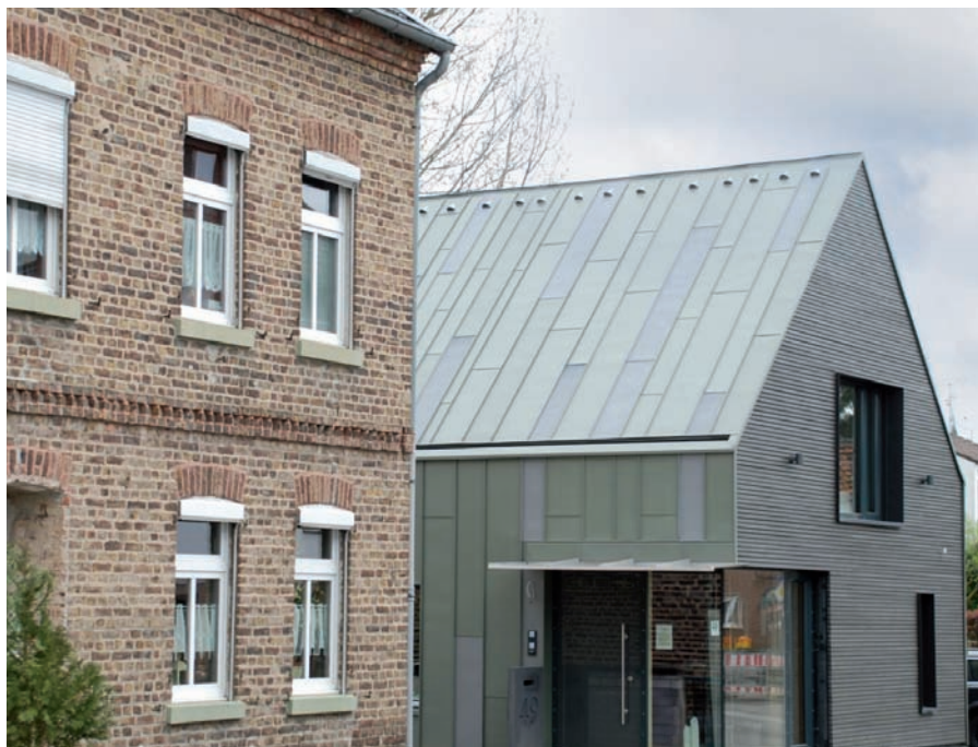
Casa pasiva, Wachtberg (Alemania) - Arquitecto: Raum für Architektur, Kay Künzel und Partner Técnica: Junta alzada VMZINC® en ANTHRA-ZINC®, QUARTZ-ZINC® y PIGMENTO® verde olivo
