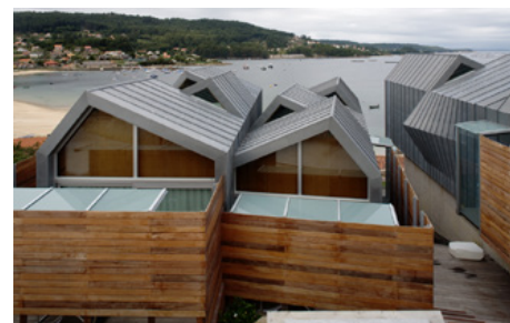
Viviendas en Vilarinho - Arquitecto Alfonso Penela Fernández
