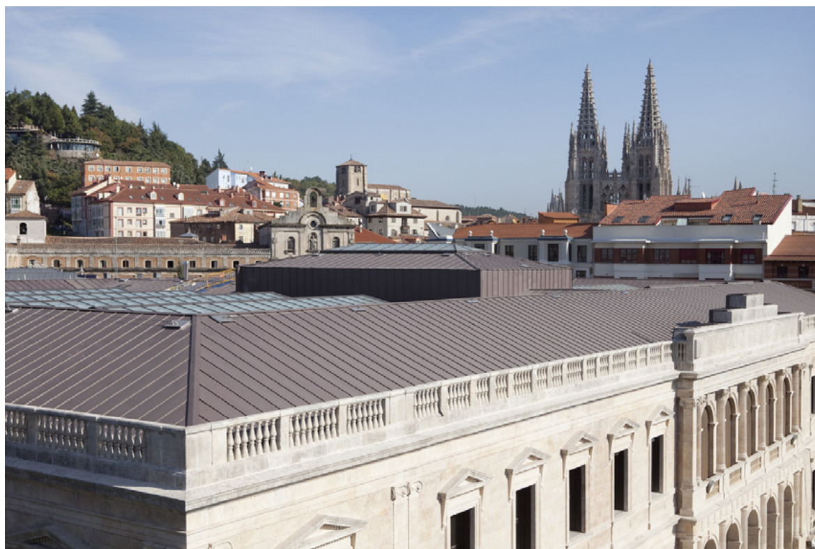
Rehabilitación Palacio de Justicia, Burgos - Arquitecto: José Andrés García Redondo.
