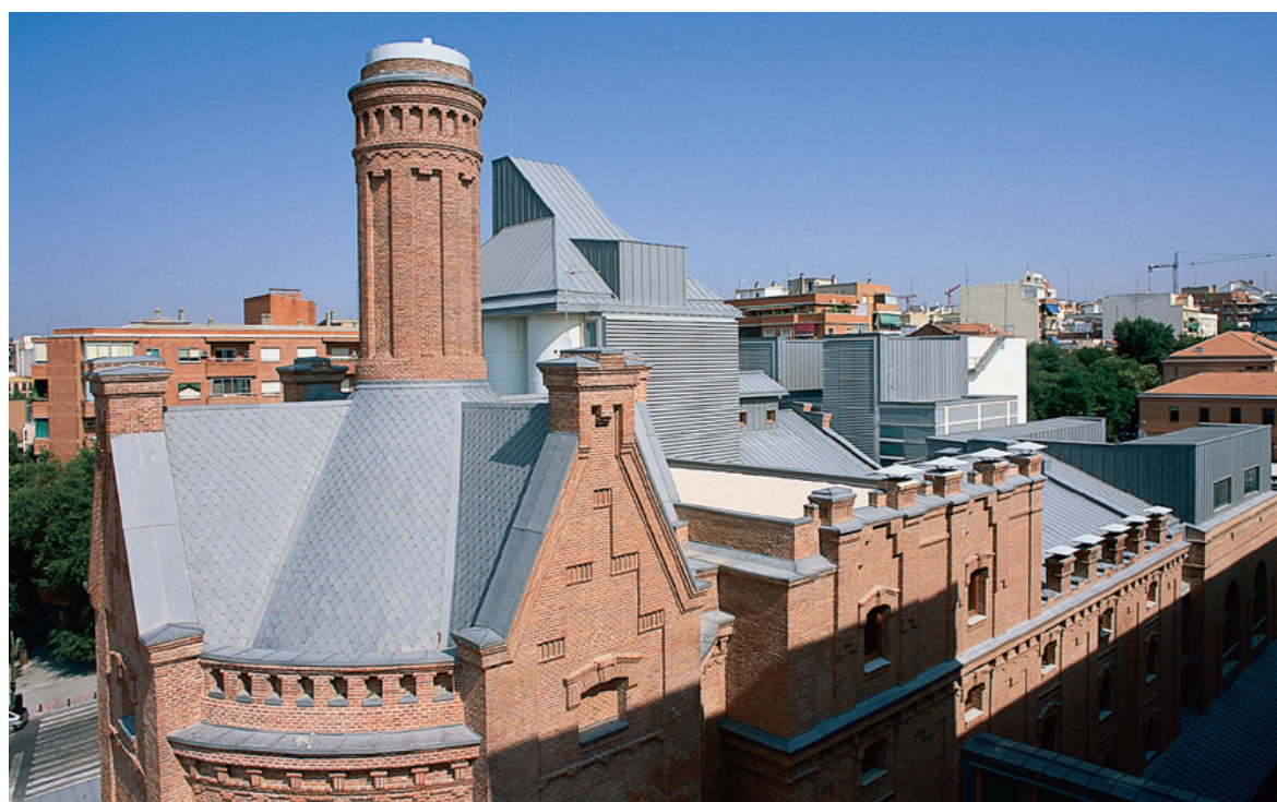
Archivo regional de la Comunidad de Madrid. Mansilla y Tuñón arquitectos
