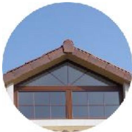
Detalle de tapón de cumbrera y remate lateral
