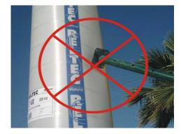
No aplicar el puntal directamente sobre el encofrado
