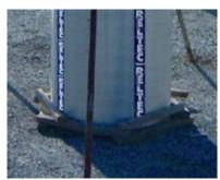
Fijar la base del encofrado, asegurando la estabilidad durante el llenado.
