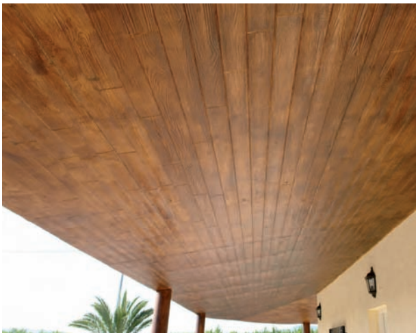
Acabado final en barniz. / EN.Final finish with varnish. / FR.Finition vernis. / DE.Betonbau mit Lackanstrich.
