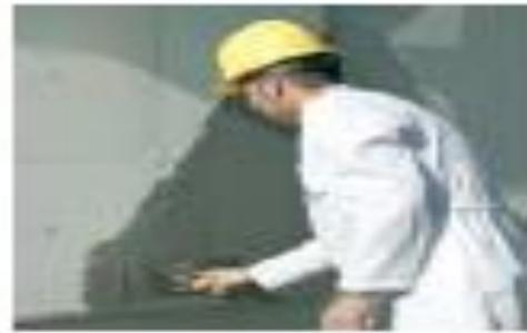
5º Colocación de la malla con la capa final de mortero base.
