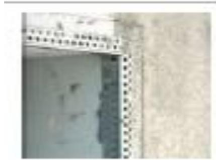
4º Imprimación del mortero base sobre las placas.
