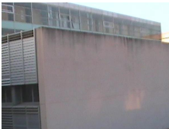
Fig. 8: Puentes térmicos en fachada norte del edificio 1. Fuente: Autor.
