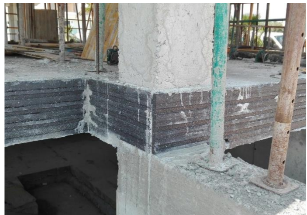
Fig. 20: Producto TR-Canto forjados colocado en obra (3).
