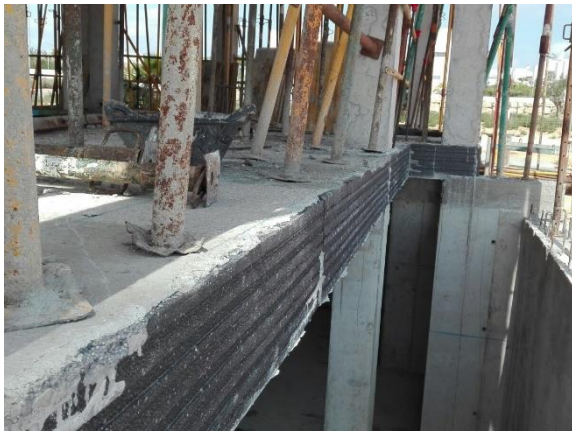
Fig. 19: Producto TR-Canto forjados colocado en obra (2).
