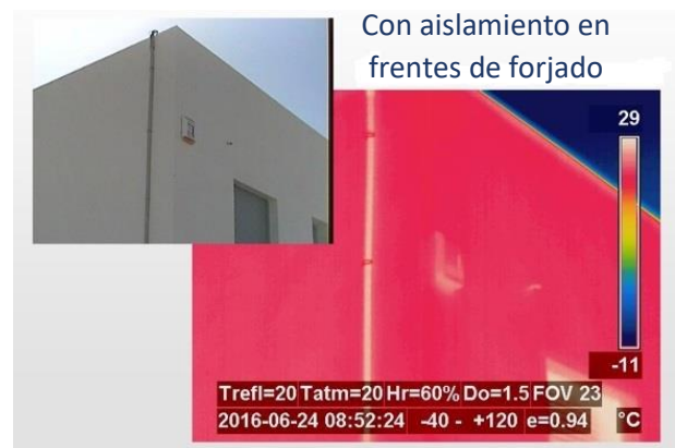
Fig. 7: Ausencia de puentes térmicos en el edificio 2. Fuente: Autor.
