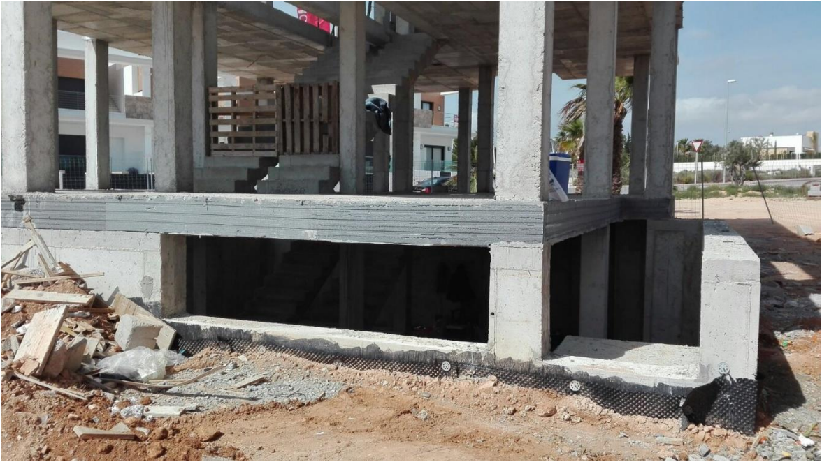
Fig. 18: Producto TR-Canto forjados colocado en obra.
