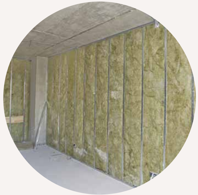
Cloison de plaque de plâtre PP 78/600(48) P
