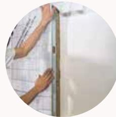
2. **Doblar la membrana** en las partes horizontales de la ventana y fijar con masilla o cinta adhesiva de doble cara.
