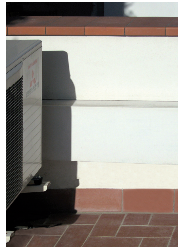
Rehabilitación de viviendas
