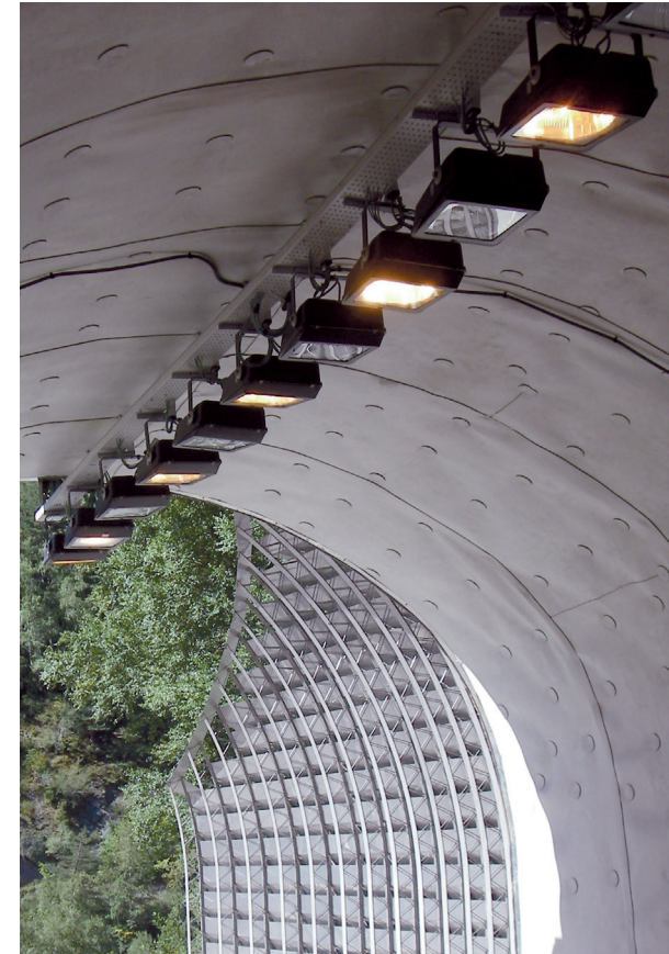
Infraestructura viaria: túnel
