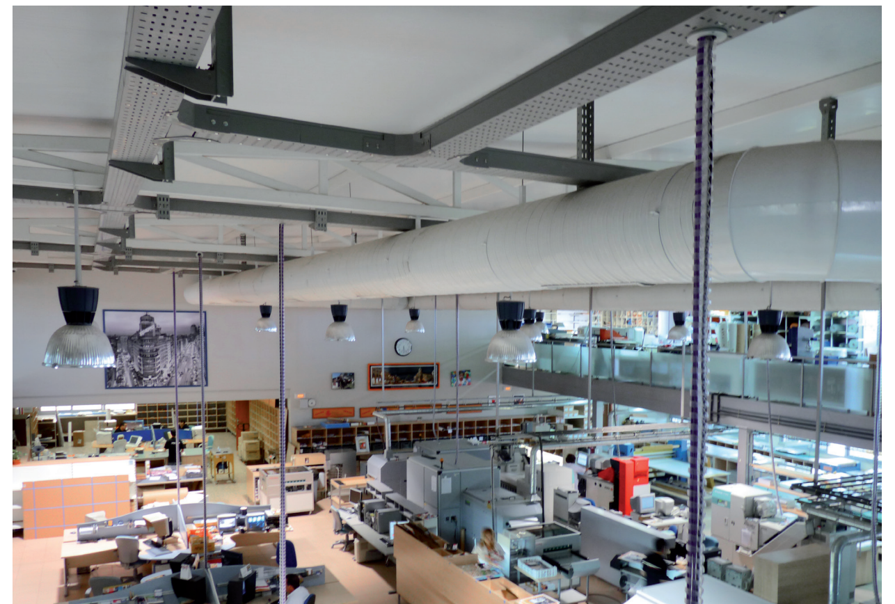
Nave industrial: oficina
