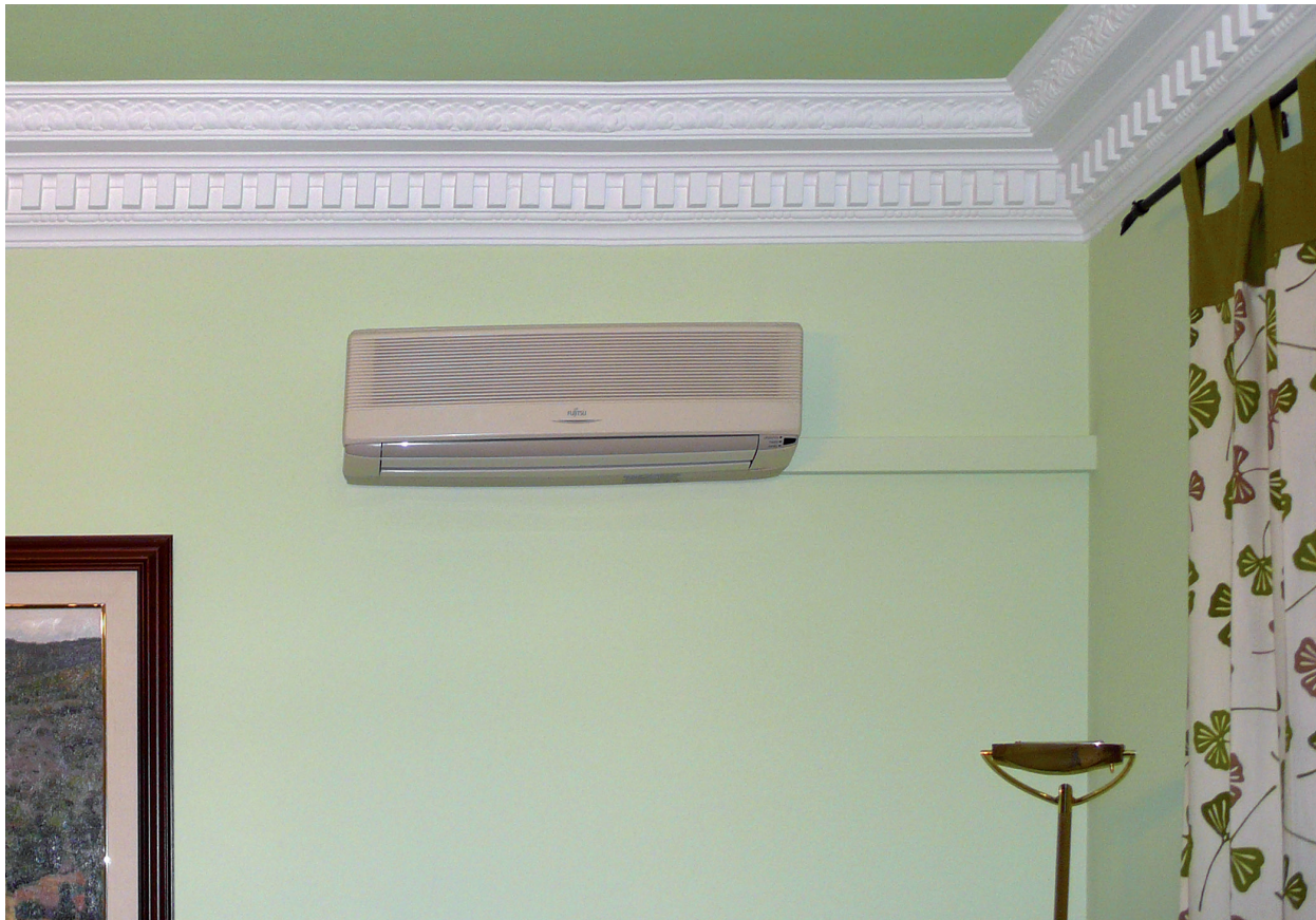
Rehabilitación de viviendas
