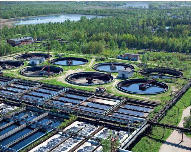
Tratamiento de aguas
