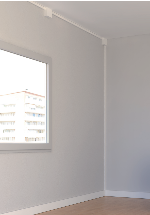
Rehabilitación de viviendas
