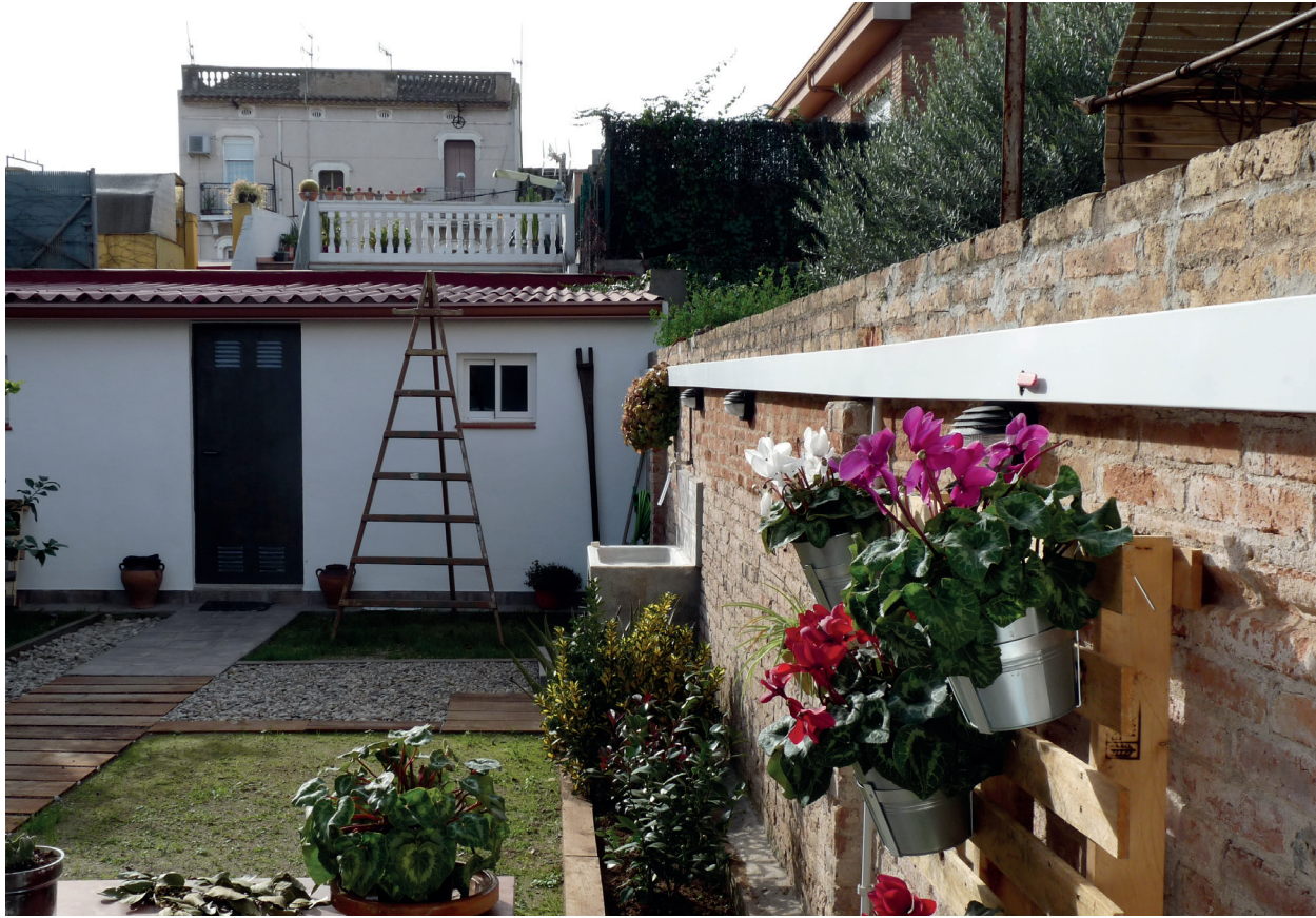
Rehabilitación de viviendas
