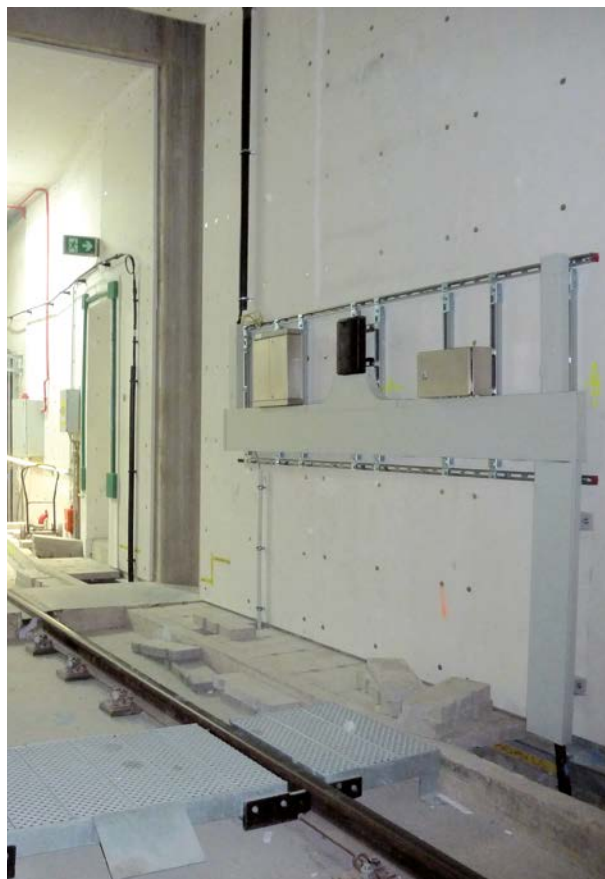
Infraestructura ferroviaria: túnel
