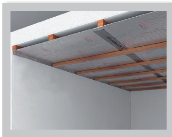
Rastrelado para el acabado del techo.
