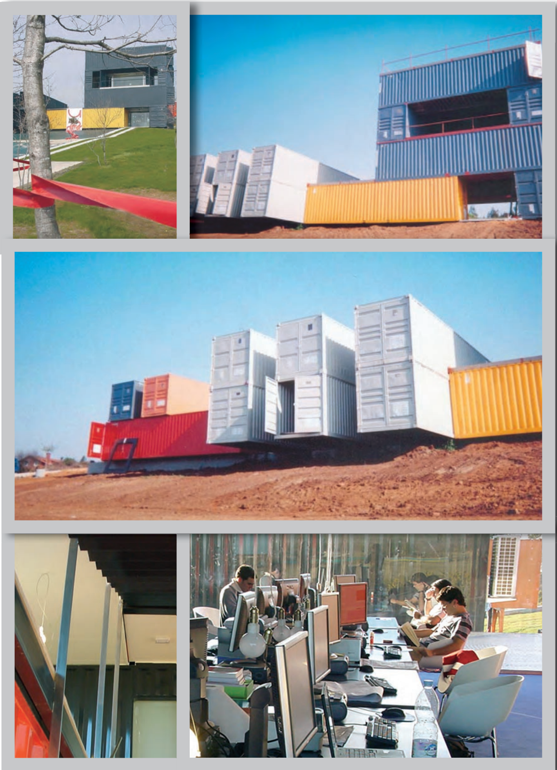
Acabado contenedores marítimos habilitados para vivienda.
