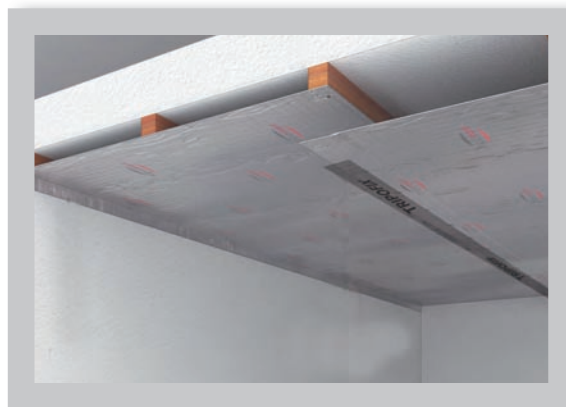
Colocación aislante. Retorno del aislante en pared.
