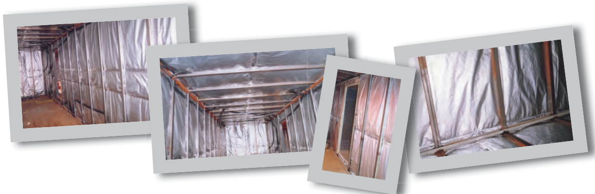
Instalación de Tripomant en el interior de contenedores
