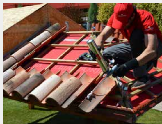
Agujeros pre-marcados para fijación de las canales.
