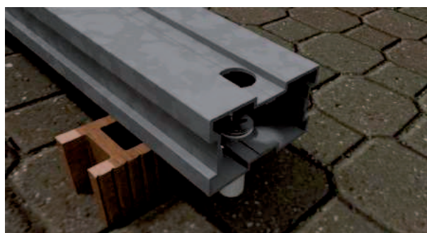
6. Rastrel atornillado al suelo sobre cuña de tarima.
