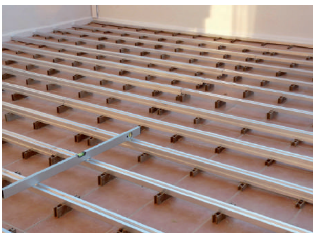
23. Rastrelado para junta perdida.
