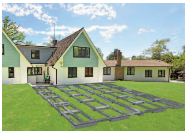
13. Estructura rastrelado con losetas.
