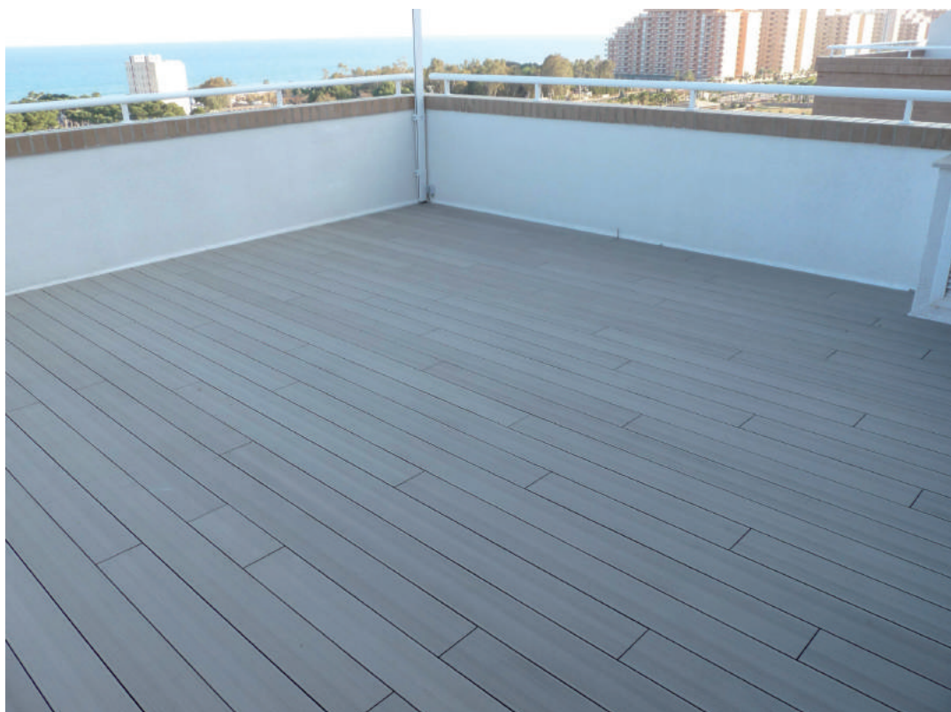
25. Tarima montada a junta perdida.
