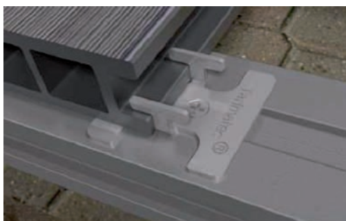
18. Detalle de sujeción de lama con clip
