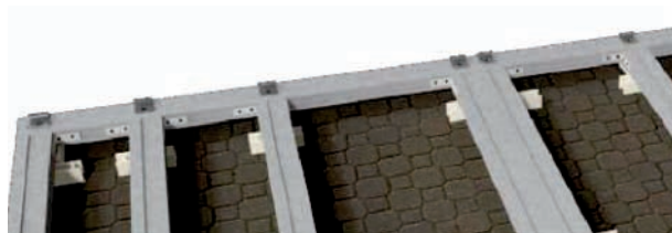
33. Inicio de instalación con clip de inicio.
