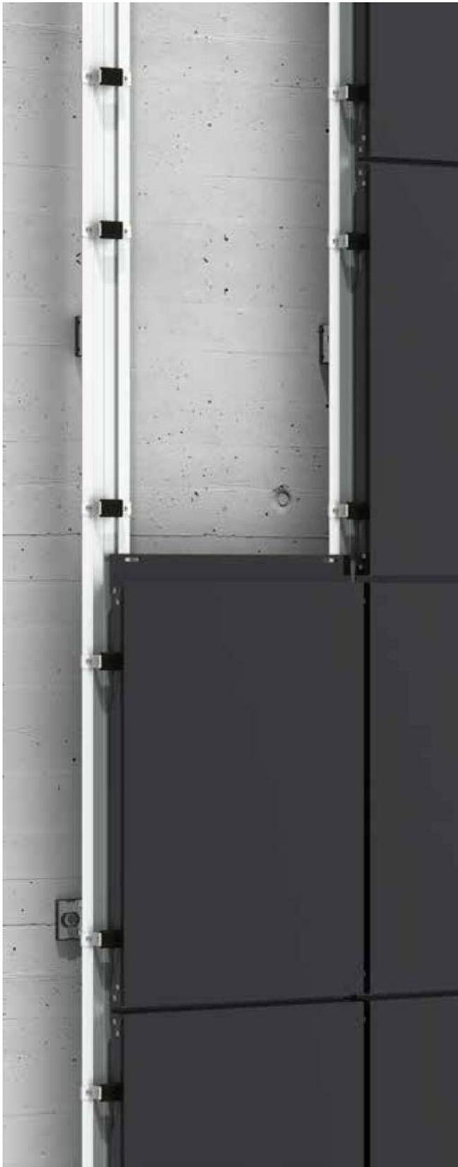
El **STB-T-CH** es un sistema kit a base de bandejas colgadas procedentes de **panel composite STACBOND STRUGAL para montaje de fachadas ventiladas**. Es un sistema de fijación oculta, versátil y de rápido montaje, en el cual las modulaciones de las bandejas pueden ser tanto horizontales como verticales. El sistema STB-T-CH cumple con todos los requisitos para poder ejecutar los recubrimientos arquitectónicos más vanguardistas.
