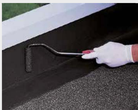
Fig 3.3.7. Encuentro con paramento vertical retranqueo.
