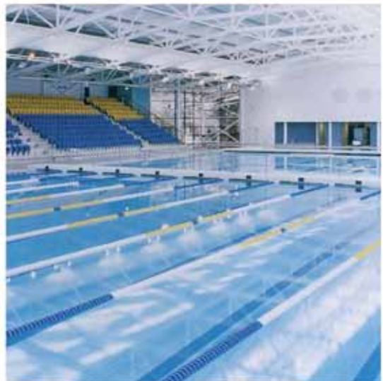
Centro de ocio Tollcross Park, Glasgo°, Reino Unido
