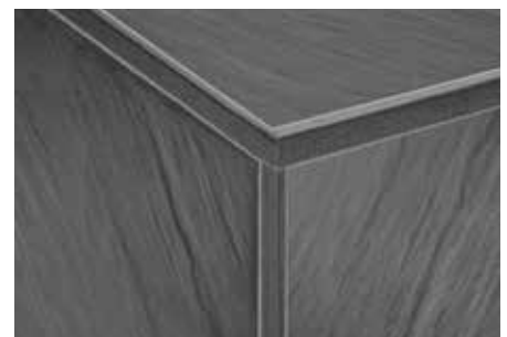
Ejecución de esquinas con corte a inglete
