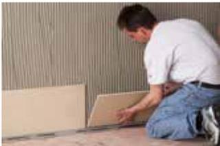
Para la impermeabilización de juntas de movimiento o perimetrales flexibles se comercializa la banda Schlüter-KERDI-FLEX en dos anchos: 12,5 o 25 cm.
