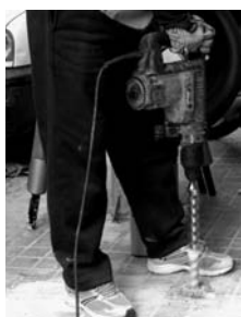
2 Perforación orificios
