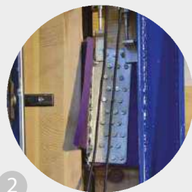
TITAN madera/madera con perfiles acústicos
