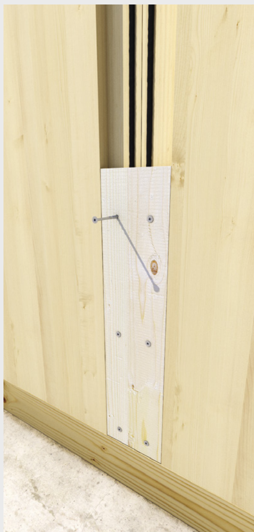
Fixação paredes em CLT > com parafusos HBS diâmetro 6 mm.
