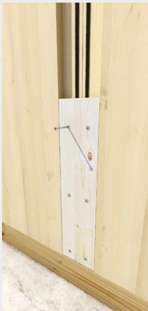
Fijación de paredes de CLT con tornillos HBS diámetro 6 mm.
