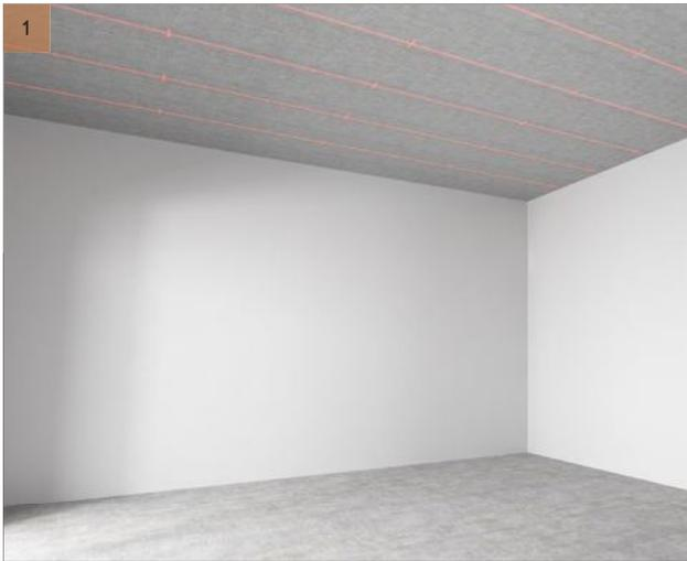
Use un láser para marcar simétricamente los puntos de perforación en líneas rectas. Marque los puntos de perforación en el techo cada 1200 mm
