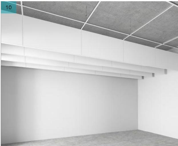
Fije los Rockfon Universal Baffles restantes a la perfilería T24 y alinéelos utilizando las perforaciones en el extremo de los baffles.
