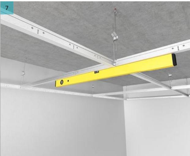
Ajuste el nivel de los perfiles T24 utilizando muelles de cuelgues rápidos. Asegúrese de que la perfilera esté nivelada antes de instalar baffles.
