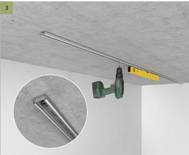
Fije los Rieles de Soporte al techo y nivélelos adecuadamente. Cuando sea necesario, considere el uso de juntas flexibles, p. ej. juntas de goma o espuma, entre el Riel de Soporte y el techo para compensar la superficie desigual del techo y nivelar los Rieles de Soporte. Recuerde usar fijaciones adecuadas para el techo. Si es necesario, utilice el Tope Final al extremo del Riel de Soporte.
