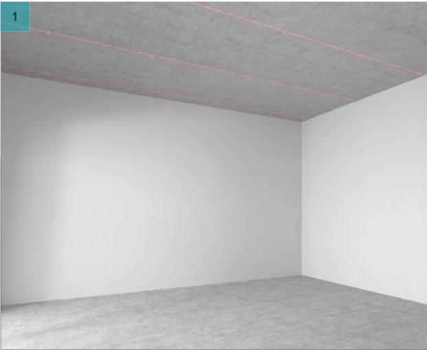
Use un láser para marcar simétricamente los puntos de perforación en líneas rectas. Marque los puntos de perforación en el techo cada 1200 mm, tanto en largo como en ancho
