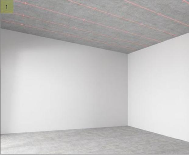
Use un láser para marcar simétricamente los puntos de perforación en líneas rectas. Marque los puntos de perforación en el techo, en los extremos del Riel de Soporte y uno en el medio.
