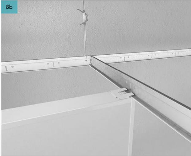
Fije el Rockfon Universal Baffle a la perfilería suspendida T24. Puede usar las ranuras de los perfiles T24 para alinear los Rockfon Universal Baffles
