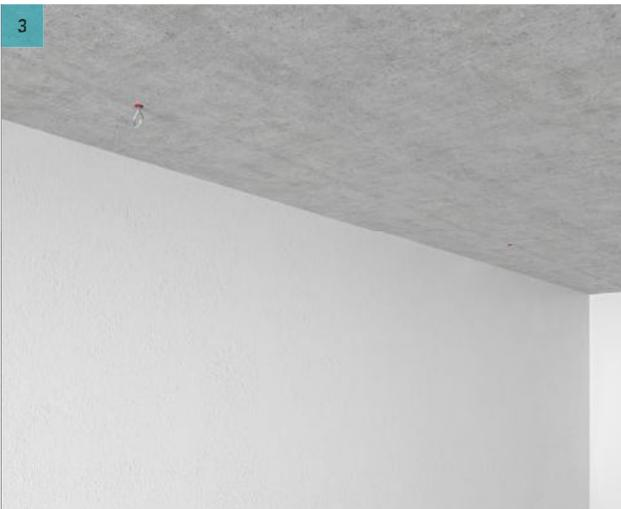
Use fijaciones que adecuadas para el techo. Inserte un cáncamo cerrado en el techo
