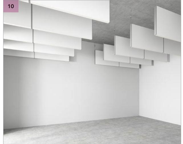
Alinee el Rockfon Industrial Baffle usando las perforaciones en el extremo del baffle.
