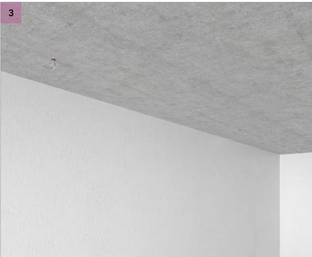
Inserte los tacos en los agujeros en el techo. Utilice fijaciones adecuadas para el techo.
