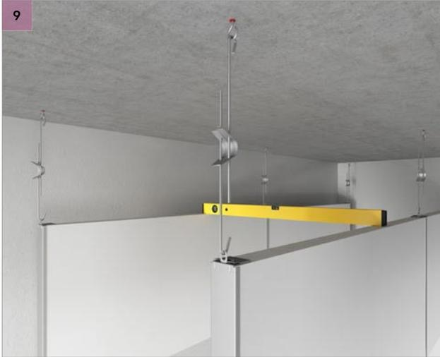
Coloque un nivel encima o debajo del Rockfon Industrial Baffle para garantizar su uniformidad. La nivelación se puede hacer comprimiendo el muelle de cuelgue rápido para ajustar la altura de los baffles.
