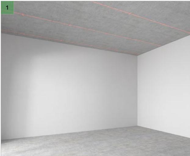
Antes de fijar los Soportes de Fijación Directa ECR, asegúrese que el techo es uniforme. Si es necesario, elimine cualquier irregularidad. Use un láser para marcar simétricamente los puntos de perforación en líneas rectas. Marque en el techo los puntos de perforación cada 1200 mm.
