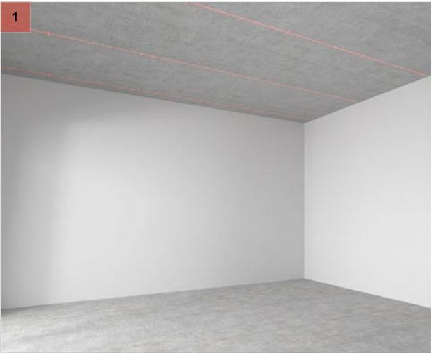
Use un láser para marcar simétricamente los puntos de perforación en líneas rectas. Marque en el techo los puntos de perforación cada 1200 mm, tanto en longitud como en anchura.
