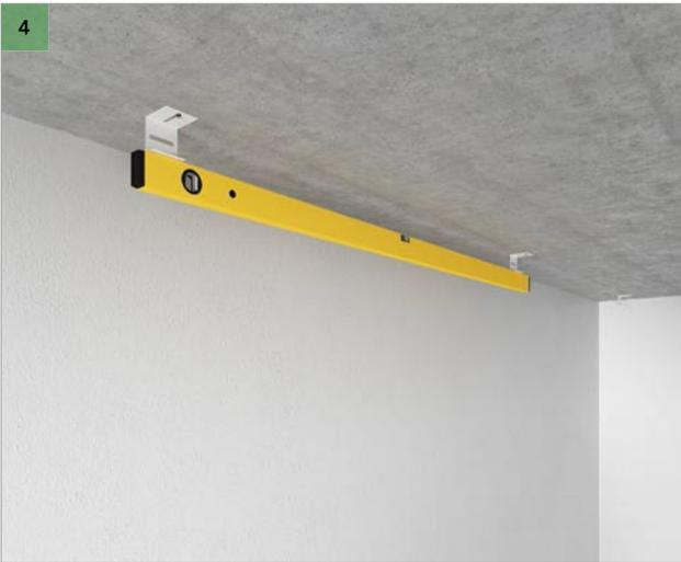
Sujete los Soportes de Fijación Directa ECR al techo cada 1200 mm, como se indica. Asegúrese de que la posición de los soportes esté alineada y nivelada. En entornos exigentes, recuerde utilizar fijaciones resistentes a la corrosión de clase D.
