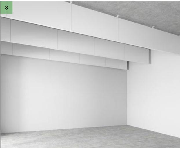
Fije los baffles Rockfon Humitec restantes al techo y alinéelos utilizando la perforación en el extremo de los baffles. Cuando sea necesario, puede ajustar el espacio entre los baffles Rockfon moviéndolos en los agujeros ovales dentro de los soportes de fijación directa ECR.
