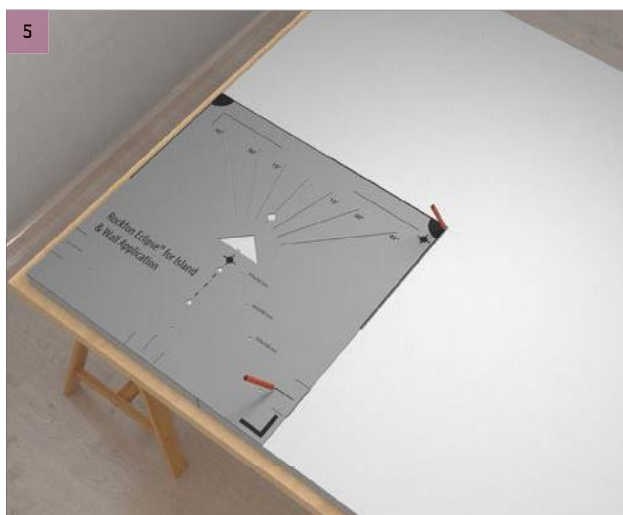
Coloque la plantilla en la esquina inferior izquierda de la parte trasera del absorbente mural Rockfon Eclipse. Con un lápiz, marque las líneas centrales, utilizando la esquina superior derecha de la plantilla y la posición del espaciador. Vea 5 - Resultado.
