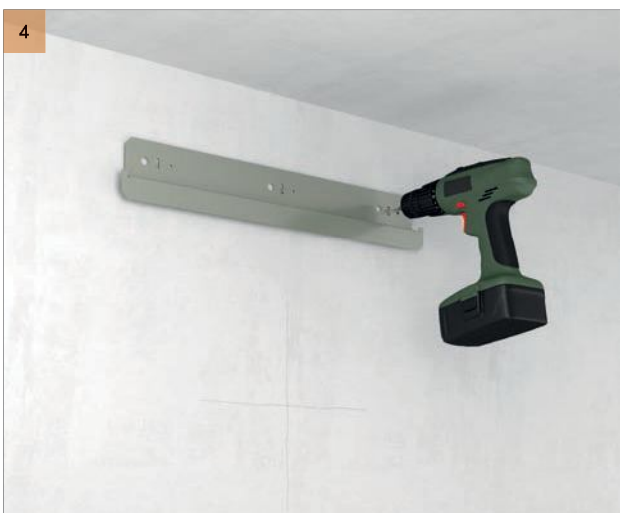
4 Perfore la pared e instale el soporte de fijación de pared
