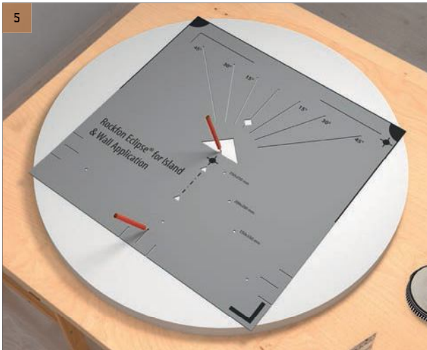
Coloque la plantilla en la parte trasera del absorbente mural Rockfon Eclipse. Con un lápiz, marque la base del triángulo y la posición del espaciador. Vea 5 - Resultado
