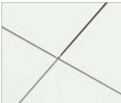
El espacio de 8 mm entre los paneles crea una sombra y oculta parcialmente la perfilería creando un aspecto flotante.
