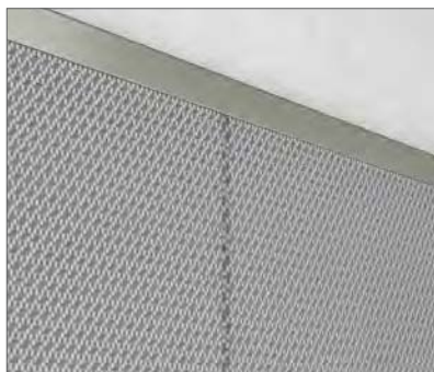
Una conexión oculta bonita y cuidada entre los paneles y el perfil de cubierta perimetral de aluminio anodizado.
